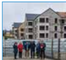
Chantier Hamon Vaujoieux, mai 2023. 30 logements seront livrés en 2024.
